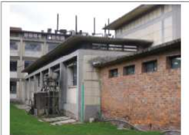
Foto 3 : FACHADA POSTERIOR BLOQUE DOS DONDE SE VE ADOSADA CONSTRUCCION EN LA DRILLO TOLETE
