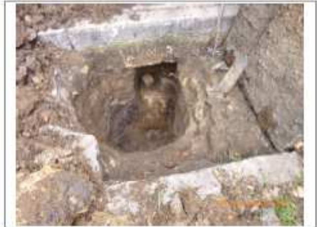
Foto 2: EXPLORACION CIMENTACION Y TIPO DE ZAPATA ENCONTRADO
