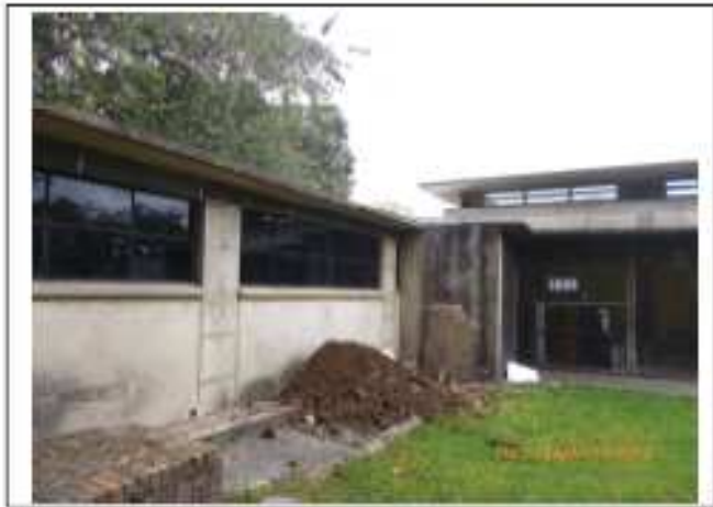
Foto 1: APTIQUE BLOQUE 2 SOBRE FACHADA COSTADO ORIENTAL
