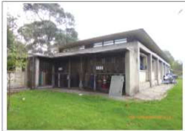
Foto 3: PANORAMICA BLOQUE 2 SOBRE COSTADO ORIENTAL
